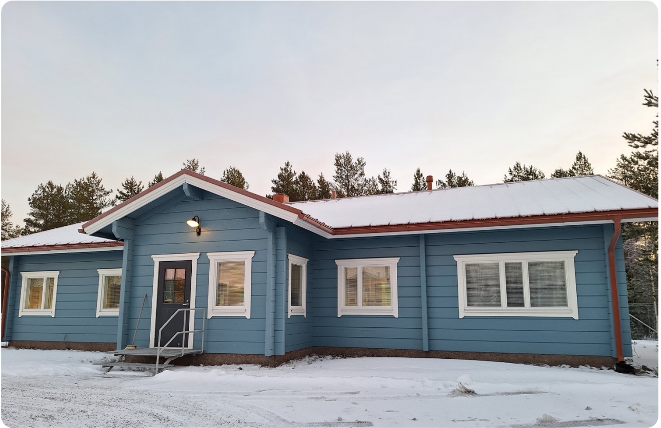
Millespakan jätekeskuksen toimitiloja parannettiin uusimalla toimistorakennuksen katto ja sadevesijärjestelmä.
